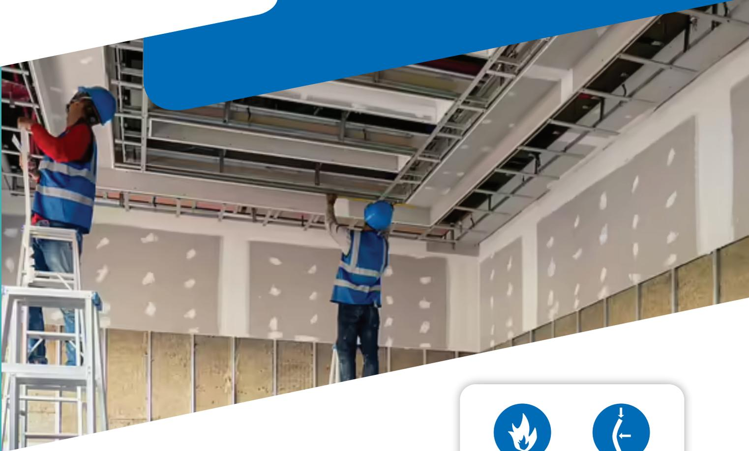
Perfiles livianos metálicos de acero galvanizado fabricado mediante proceso de laminado en frío en chapa 0,5mm con recubrimiento de zinc para protegerlos de la corrosión.
