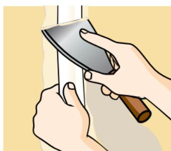
**Paso 3 - Aplicación Masilla Placo® – Recubrimiento de cinta:**
