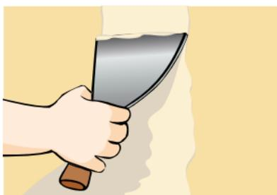
**Paso 4 - Aplicación Masilla Placo® - Recubrimiento final:**
